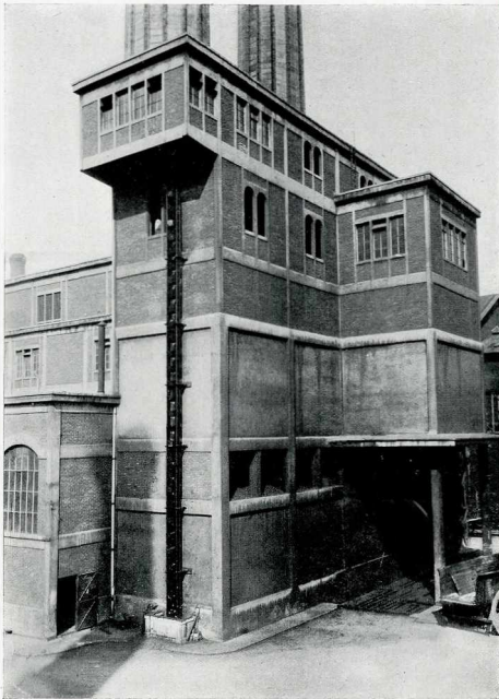
Fig. 181. — SOCIÉTÉ ANONYME DE LA RAFFINERIE SÖMMIER. — Installations, aux Usines de Paris, de 12 Chaudières Babcock et Wilcox , formant une surface totale de chauffe de 3 000 mètres carrés, avec Surchauffeurs et Grilles mécaniques, Tuyauteries et Transporteurs mécaniques : Systèmes Babcock et Wilcox .
