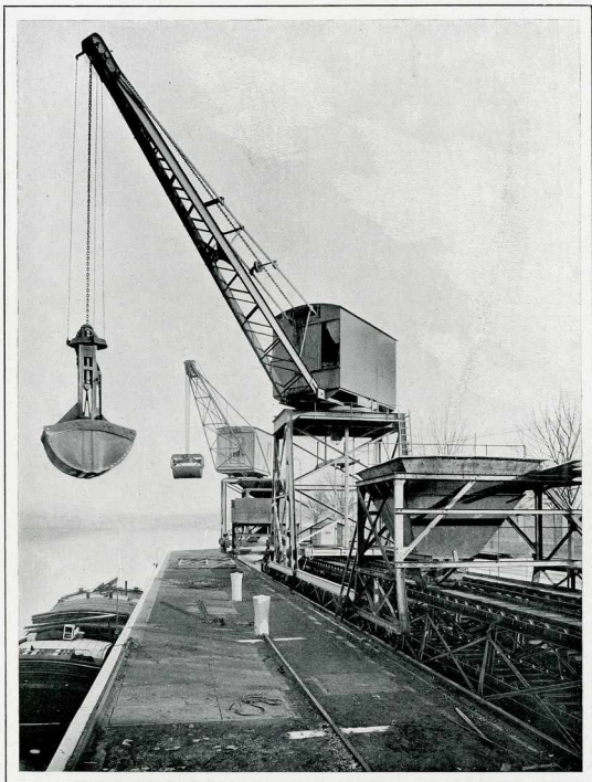
Fig. 208. — SOCIÉTÉ D'ÉLECTRICITÉ DE PARIS. — Installation, à l'Usine de Saint-Denis (Seine), d'un Système complet Babcock et Wilcox , de déchargement, transport, emmagasinement et distribution automatiques de charbon pour l'alimentation de 64 Chaudières Babcock et Wilcox , formant une surface totale de chauffe de 31 520 mètres carrés, avec Surchauffeurs, Grilles mécaniques et Économiseurs, Tuyauteries : Systèmes Babcock et Wilcox . Vue des Crues, Bennes piocheuses et Transporteurs à tablier métallique. (Voir aussi p. 213 à 220.)
