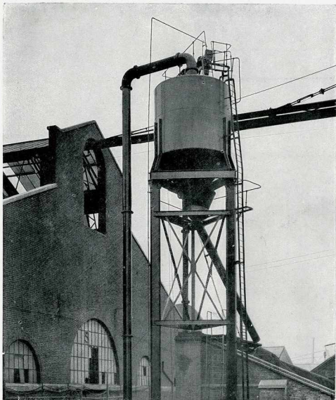
Fig. 194. — Aspirateur pneumatique des cendres et mâchefers. (Vue du Réservoir à cendres et mâchefers.)
